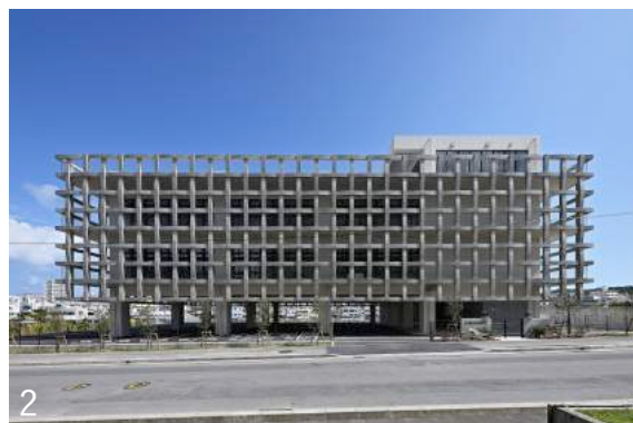
2,3: 深いバルコニーと格子によって、直射日光から室内環境を守ることができる。4: てだこ浦西駅方面からみる建物外観 5: エントランスアプローチ
