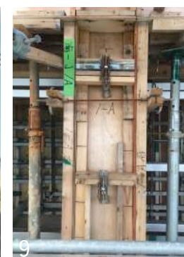
6: 合板で作成した原寸大の模型。型枠の作り方や打設の手順を検討している。7,8,9: 敷地内のヤードにて格子の縦格子の型枠をユニット化し、クレーンで立て込んでいる。
