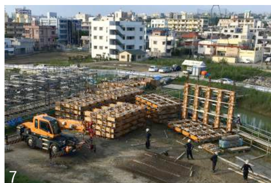
6: 合板で作成した原寸大の模型。型枠の作り方や打設の手順を検討している。7,8,9: 敷地内のヤードにて格子の縦格子の型枠をユニット化し、クレーンで立て込んでいる。
