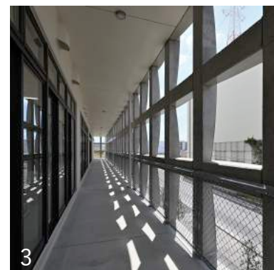
2,3: 深いバルコニーと格子によって、直射日光から室内環境を守ることができる。4: てだこ浦西駅方面からみる建物外観 5: エントランスアプローチ
