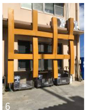
6: 合板で作成した原寸大の模型。型枠の作り方や打設の手順を検討している。7,8,9: 敷地内のヤードにて格子の縦格子の型枠をユニット化し、クレーンで立て込んでいる。
