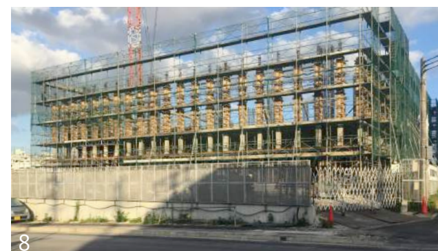
6: 合板で作成した原寸大の模型。型枠の作り方や打設の手順を検討している。7,8,9: 敷地内のヤードにて格子の縦格子の型枠をユニット化し、クレーンで立て込んでいる。
